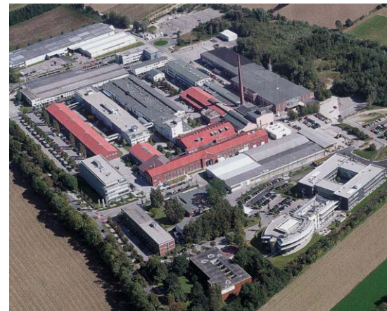
In diesem Jahr ist der Medien- und Gewerbepark der Agrob AG in Ismaning bei München um zwei weitere Gebäude und ein Parkhaus gewachsen.
